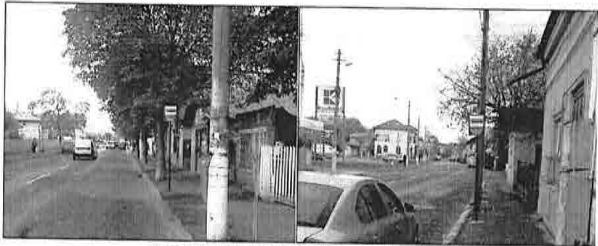
Figura 2.28. Stații de transport public neamenajate corespunzător.
