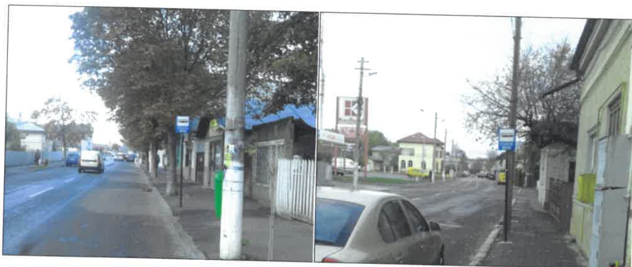
Figura 2.22. Stații de transport public neamenajate corespunzător.
