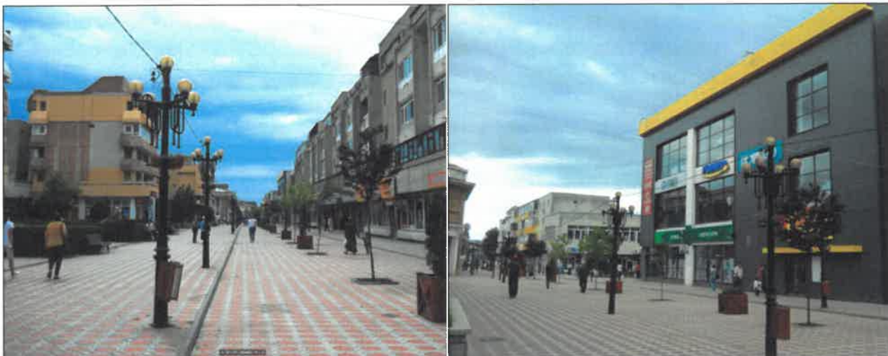
Figura 2.45. Stradă pietonală inclusă în zona cu grad ridicat de complexitate. (Sursa: http://www.primariemsarat.ro/ )
