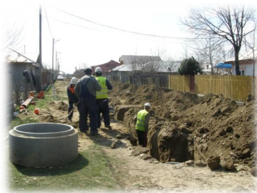
Imagine de la începutul anului 2013, cu lucrările din municipiul Râmnicu Sărat
