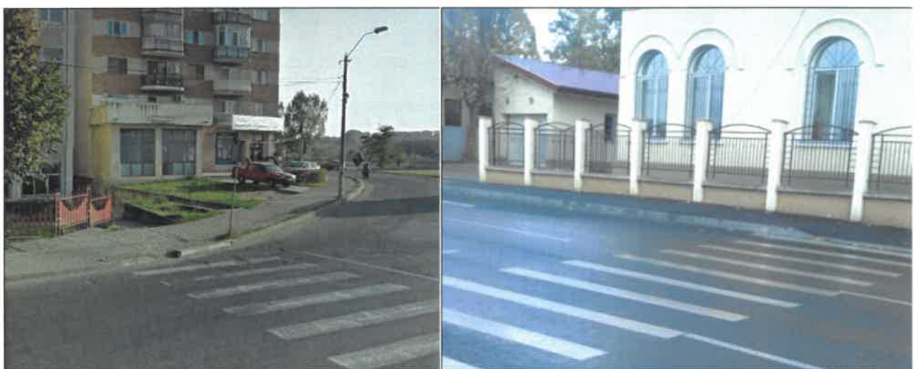
Figura 2.36. Trecere de pietoni cu probleme de accesibilitate (stânga) / accesibilizată (dreapta).
