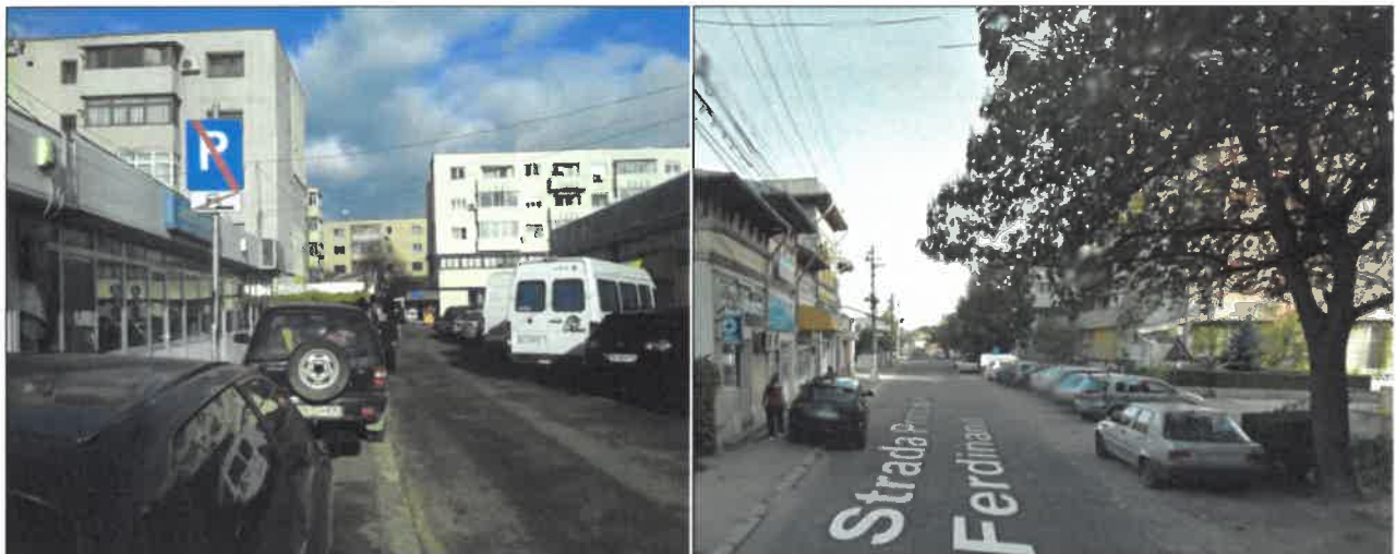
Figura 2.35. Trotuare acaparate de autovehicule parcate. (Sursa: Arhiva Consultant, Google Earth, 2016).
