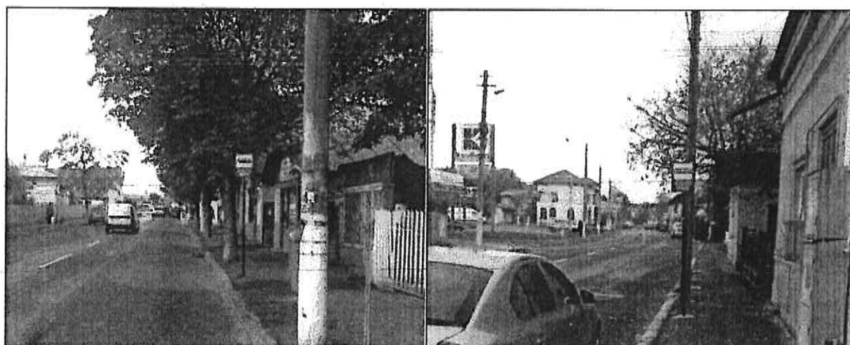
Figura 2.28. Stații de transport public neamenajate corespunzător.
