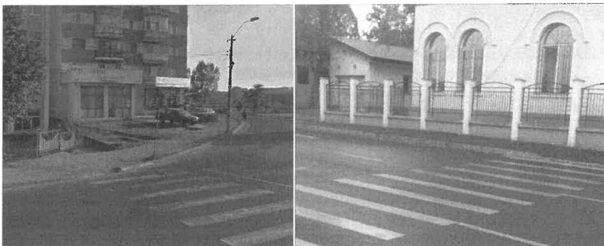
Figura 2.35. Trecere de pietoni cu probleme de accesibilitate (stânga) / accesibilizată (dreapta).
