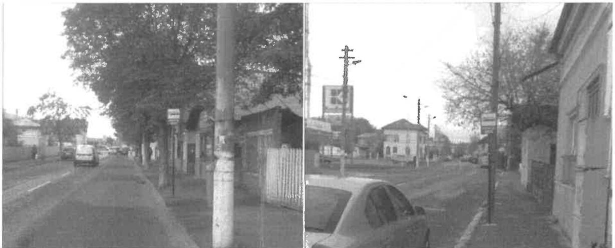
Figura 2.21. Stații de transport public neamenajate corespunzător.
