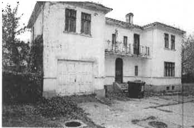
Cladire C2 Exterior – Garaj si apartamente
