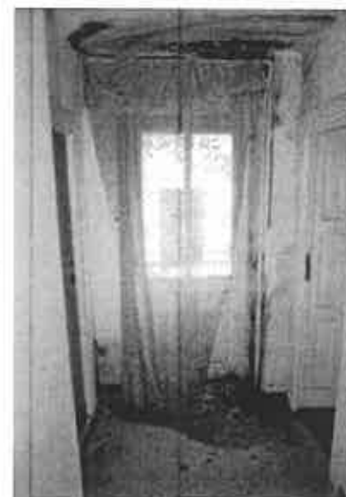
Cladire C2 Interior – Garaj si apartamente
