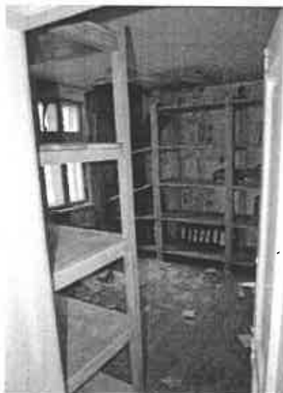
Cladire C2 Interior – Garaj si apartamente
