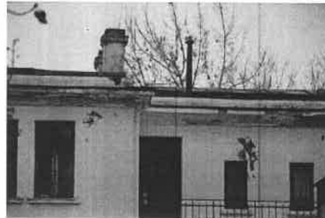
Cladire C2 Exterior – Garaj si apartamente
